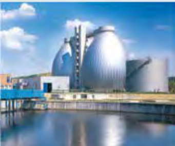
Su / Atık su istasyonu
