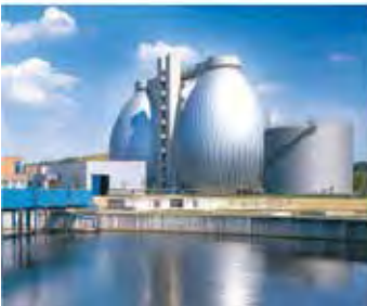
Su / Atık su istasyonu
